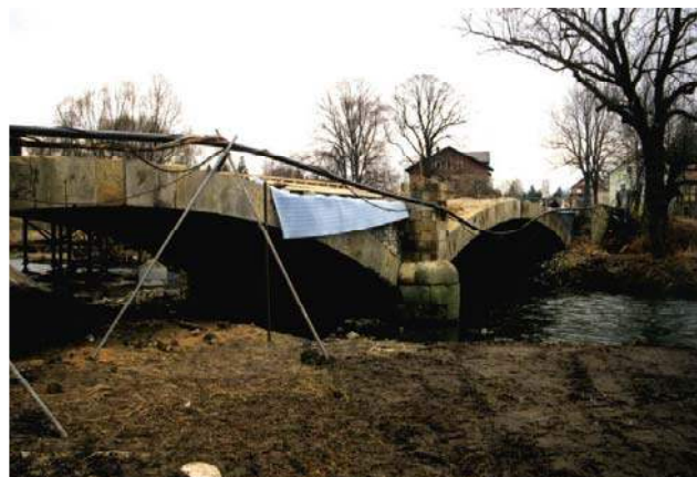
Fig. 4: Straßenbrücke mit Kreisbögen und konischen Bögen (Bauzustand)
