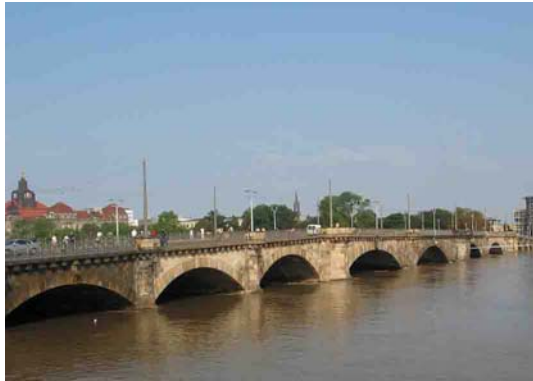
Fig. 1a: Albertbrücke in Dresden bei Hochwasser
