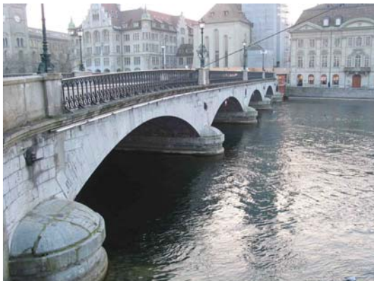
Fig. 1c: Straßenbrücke in Zürich
