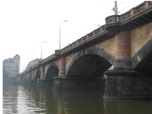
Fig. 1b: Moldaubrücke in Prag
