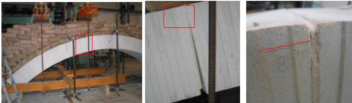
a) Bereich des aufgetretenen Risses
