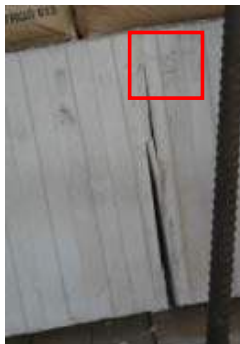
b) Klaffende Fuge und Riss im Stein
