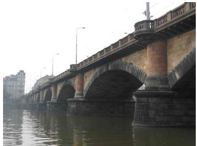
d) Moldaubrücke in Prag
