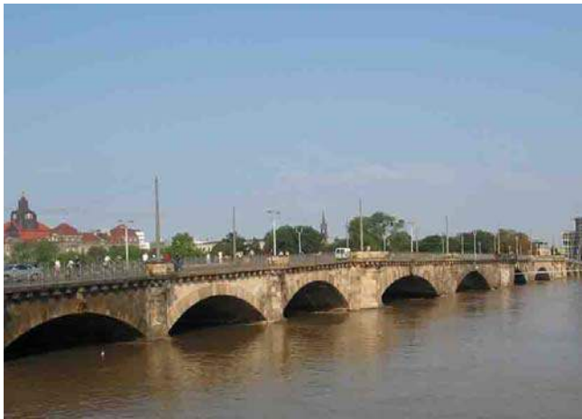
a) Albertbrücke in Dresden bei Hochwasser
