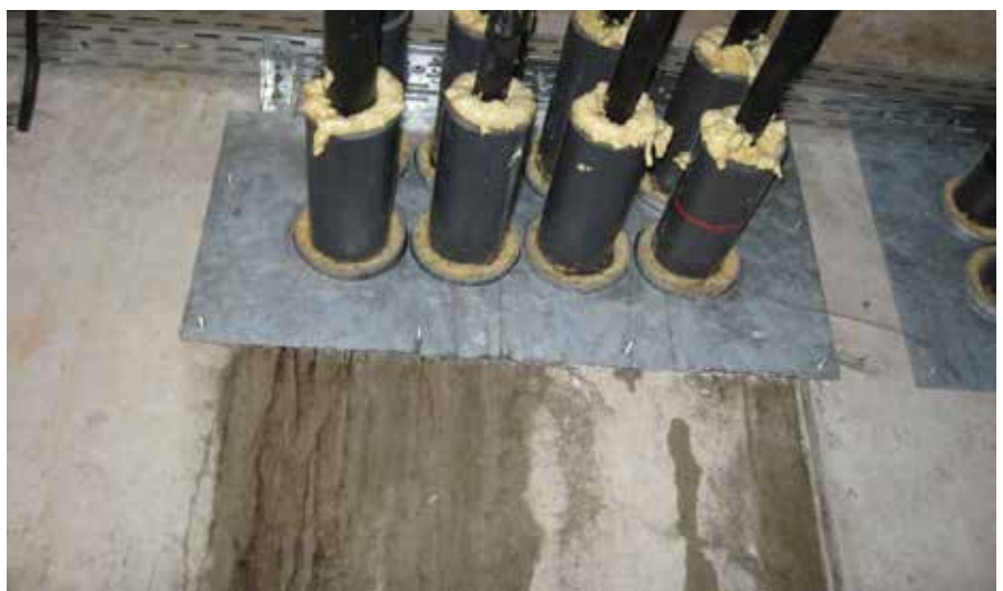
Bild 14: Mediendurchführung Kammerwand
