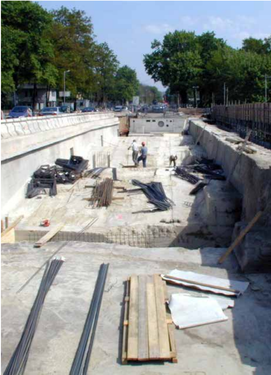
Bild 4: Herstellung der Auflagerbalken auf der abgeräumten südlichen Brückenhälfte im Juli 2002
