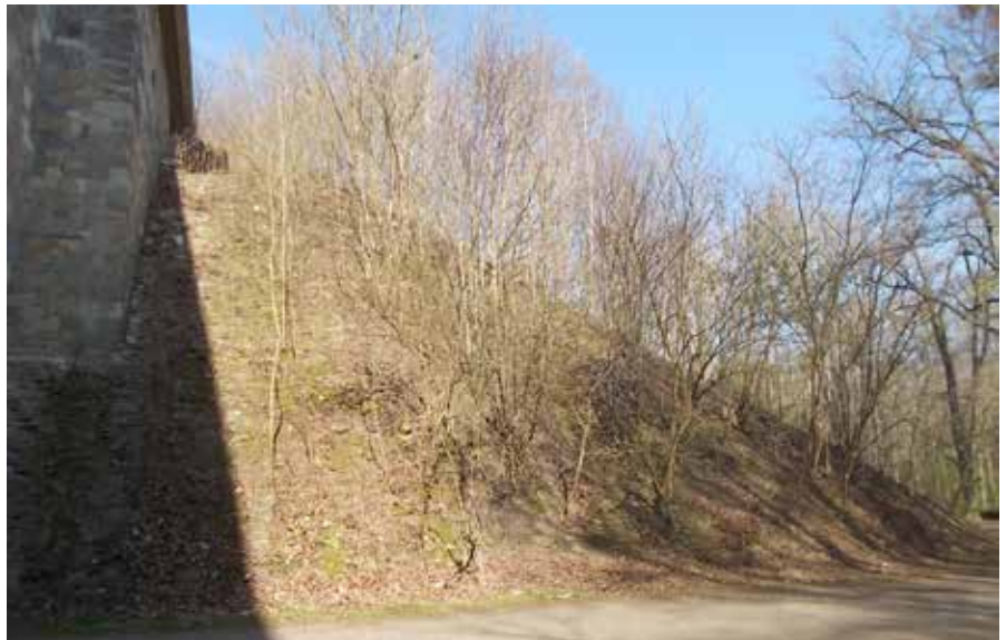
Bild 13: Befestigte Böschung mit erneutem Wildwuchs
