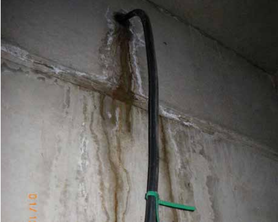
Bild 15: Durchdringung der Fahrbahnplatte für Kabel der öffentlichen Beleuchtung
