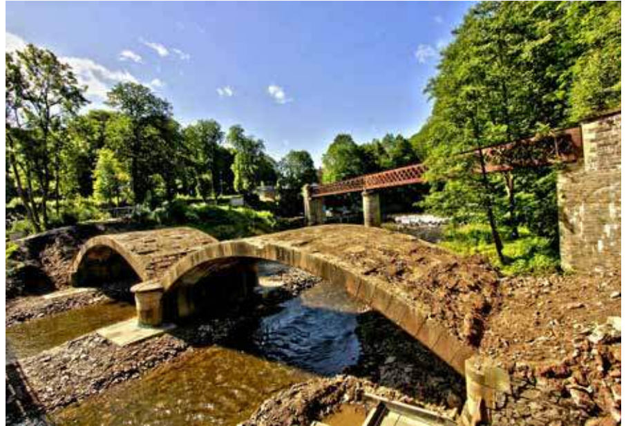
Bild 2: Freigelegtes Bogentragwerk
