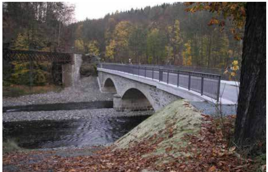
Bild 6: Oberstromseitige Ansicht des fertigen Bauwerkes
